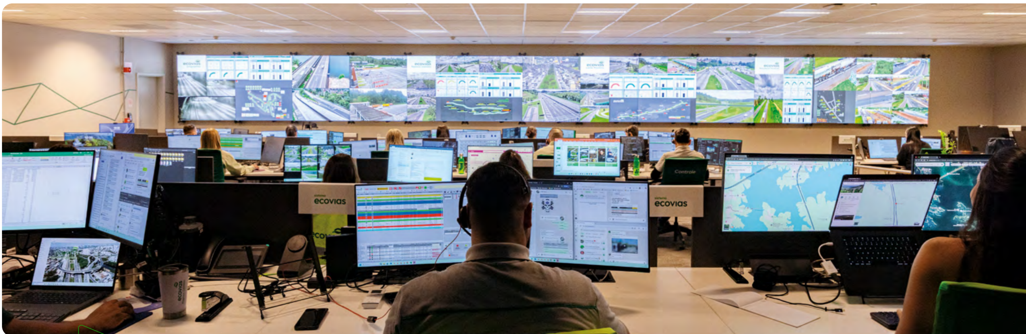
Centro de Controle Operacional Núcleo SP
