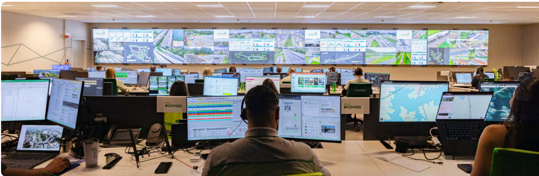
Centro de Controle Operacional Núcleo SP
