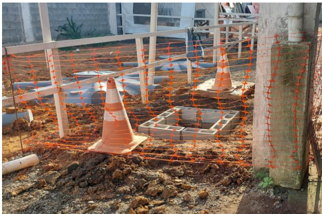
Sinalização para caixas abertas (drenagem e outras) – Cerquite + cones.
