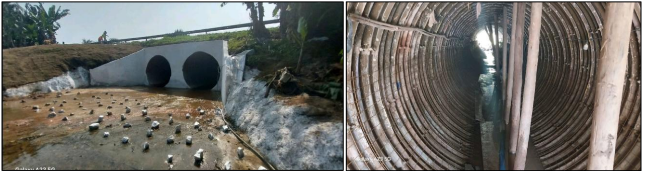
Fotos exemplificativas de espaço confinado típico encontrado nas rodovias.
